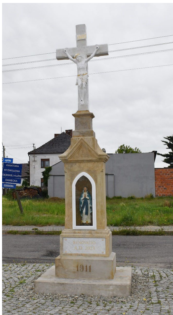
Fot. Remont krzyża przydrożnego położonego przy Placu 1 Maja w miejscowości Szczedrzyk.
