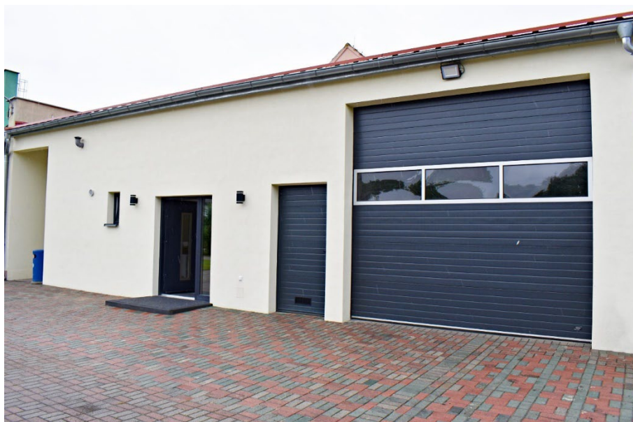
Fot. Budowa boksu garażowego na potrzeby OSP Antoniów.
