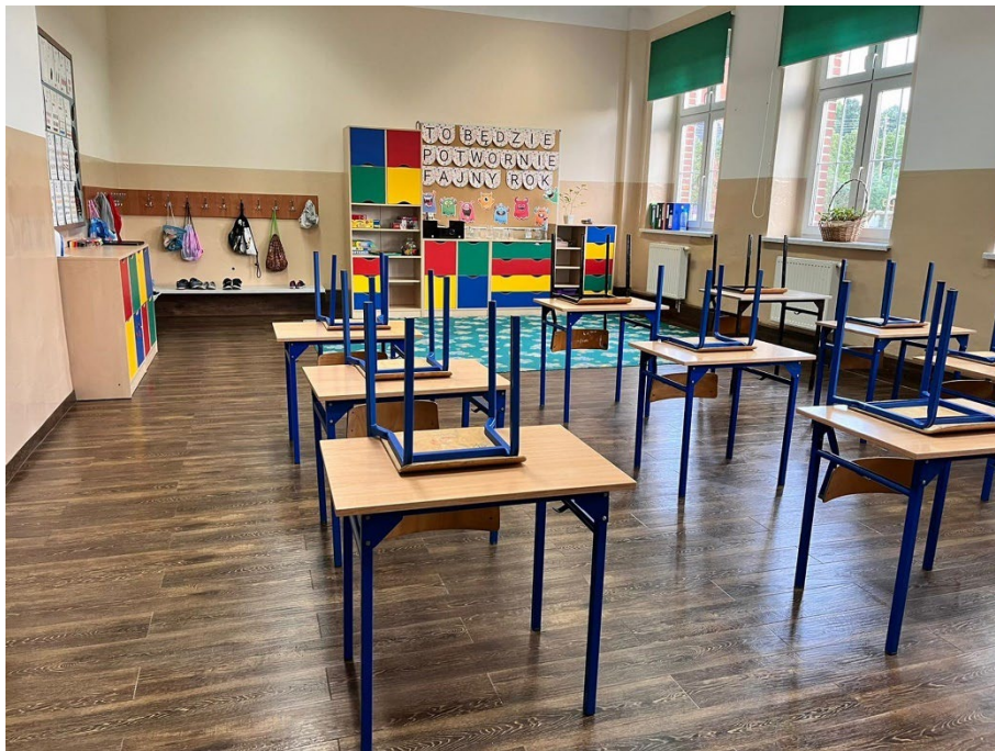
Fot. ZSP Grodziec – remont sali lekcyjnej.
