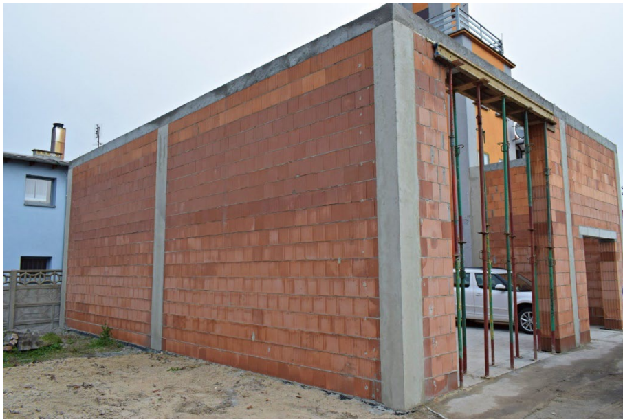
Fot. Budowa remizy OSP w Szczedrzyk
