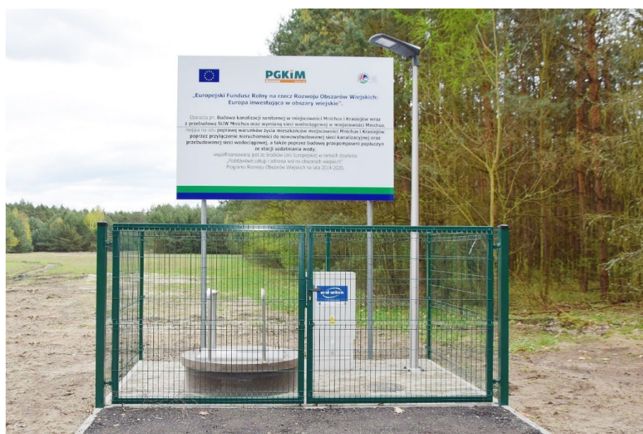
Fot. Kanalizacja w Mnichusie
