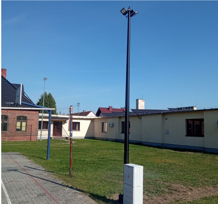
Fot. Montaż słupa wraz z dwoma lampami LED w Krzyżowej Dolinie.
