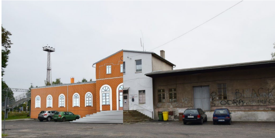
Fot. Remont dworca PKP (zdjęcie obecne + wizualizacja).
