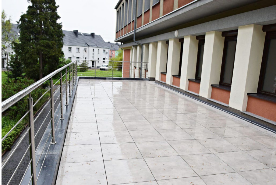
Fot. Taras Domu Kultury w Ozimku po remoncie.
