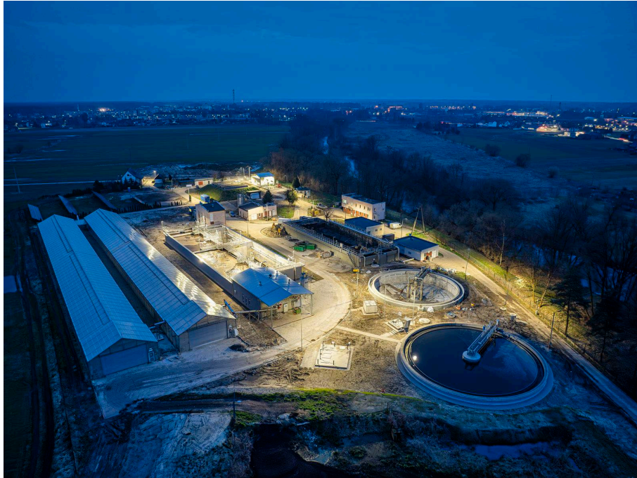
Fot. Modernizacja oczyszczalni ścieków w Antoniowie.
