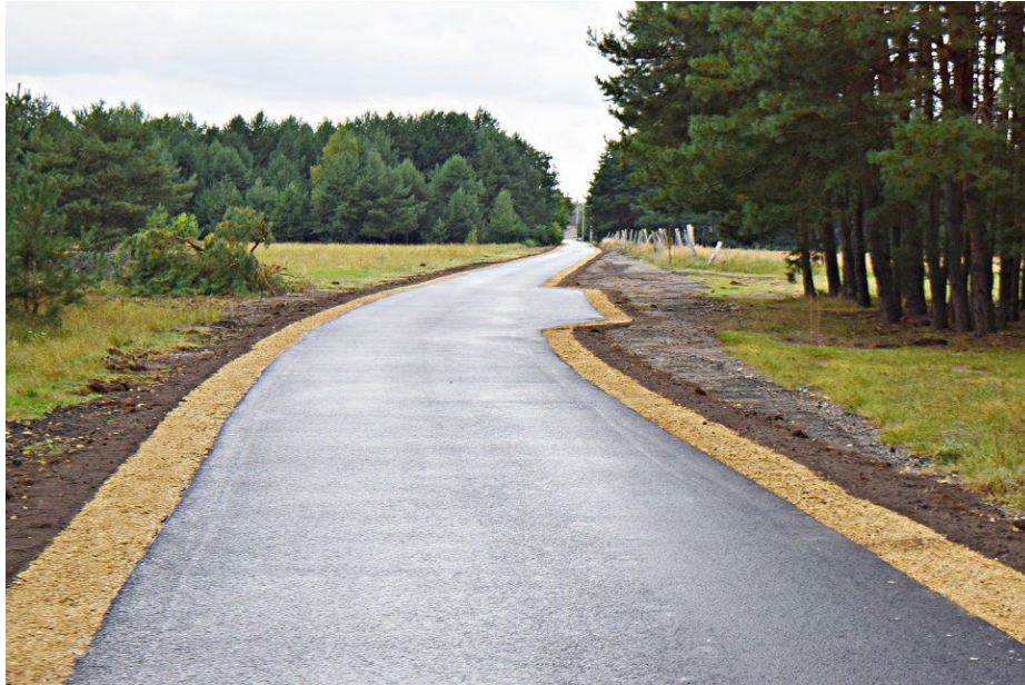
Fot. Przebudowa drogi wewnętrznej ul. Dylakowskiej dojazdowej do gruntów rolnych we wsi Biestrzynnik (ochrona gruntów rolnych i leśnych).
