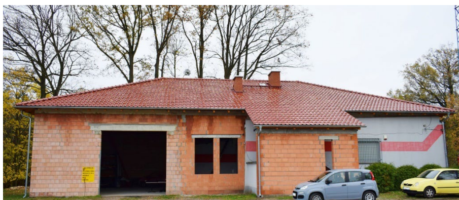
Fot. Przebudowa remizy OSP w Krasiejowie.
