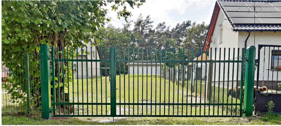
Fot. Wykonanie oraz montaż bramy wjazdowej i furtki ogrodzenia świetlicy wiejskiej w Mnichusie.
