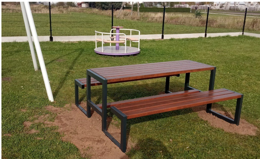
Fot. Montaż ławki parkowej wraz ze stolikiem w Nowej Schodni.
