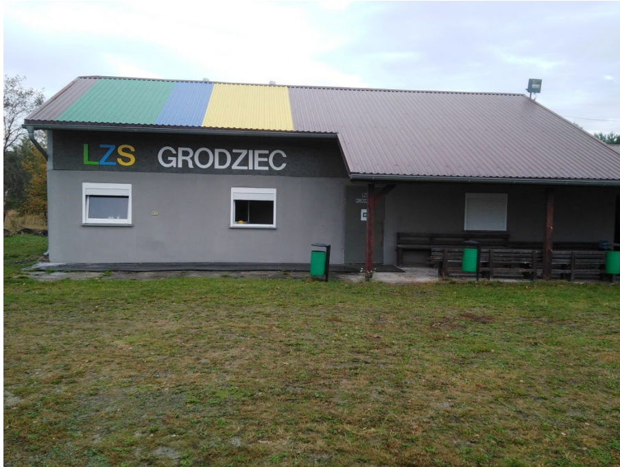
Fot. Remont budynku klubowego LZS Grodziec.
