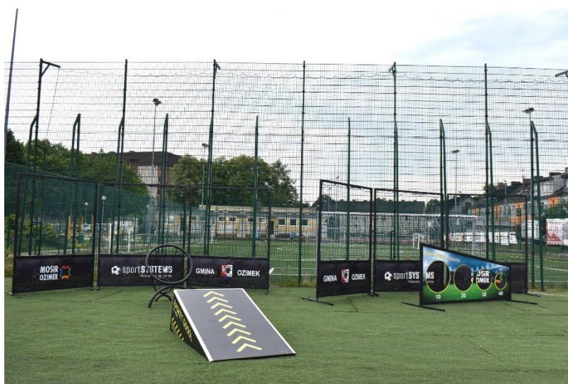
Fot. Budowa piłkarskiego placu zabaw na stadionie miejskim w Ozimku.
